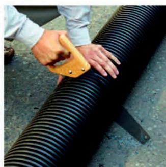
Резка трубы производится простой пилой между ребрами жесткости
